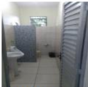
Banheiros da sede
